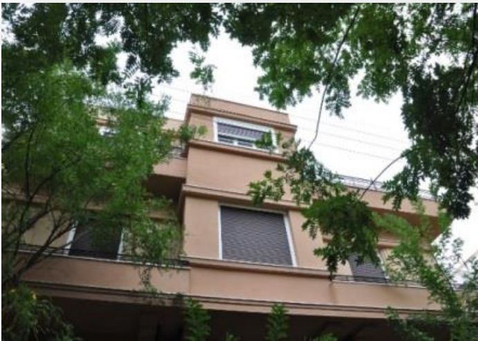
Μετά την προσθήκη ορόφου
