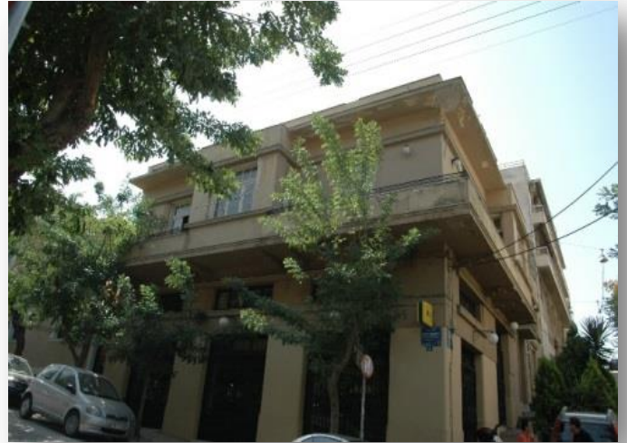
Μετά την προσθήκη ορόφου
