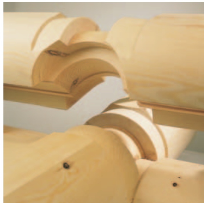
Угловое пазовое соединение для круглых бревен, запатентованное фирмой Контитюоте
